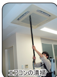
エアコンの清掃
